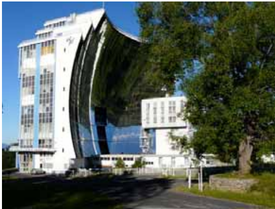
Le four solaire de 1000 kw du CNRS à Odeillo. © Daniel Gauthier. Cette image est disponible à la photothèque du CNRS, phototheque@cnrs-bellevue.fr
